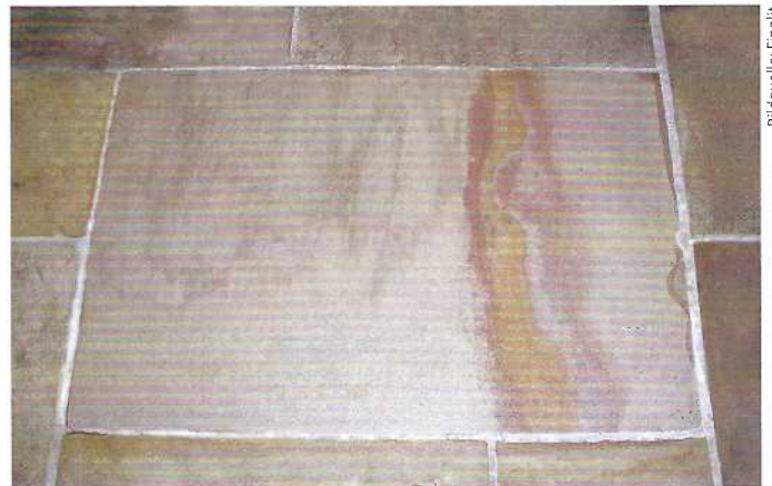
Nachher: Durch die Reinigung sind die Fliesen wieder sauber, und der Farbton ist deutlich heller. Die Fugen wurden nicht beeinträchtigt oder beschädigt.
