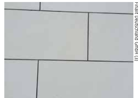
Fassadendetail nach der Reinigung.
